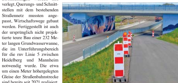
Die Arbeiten sind in vollem Gang.
