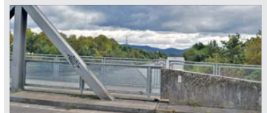
Die Ivesheimer Brücke dient seit fast 100 Jahren als Neckarquerung. Foto: Schillinger
