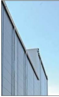
In nachhaltiger Leichtbauweise errichtet: OPAL
