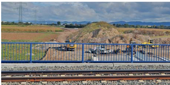
Mit dem eigentlichen Brückenbauwerk soll im Frühjahr 2025 begonnen werden.
