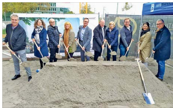
Das Projekt „Zugangsgebäude mit Fahrradparkhaus“ ist im Rahmen eines Spatenstichs auch für die Öffentlichkeit sichtbar gestartet. Von links: Carsten Südmersen, Angela Wendt, Gerhard Fontagnier, Andrea Saffering, Ralf Eisenhauer, Christian Specht, Marianne Seitz, Holger Schmid, Annalena Wirth und Thorsten Riehe. Foto: Kranczoch
