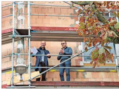
Mit dem Richtspruch durch Architekt Paul Heemskerck (v. l.) und Bauleiter Manuel Kärcher ist der Rohbau für die neue Kindertagesstätte neben der Maria-Hilf-Kirche offiziell abgeschlossen. Foto: kathma/Schuhmann
