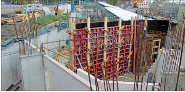
Auf der Rückseite des Hauptbahnhofes auf dem Lindenhof soll es Bewegung geben.
