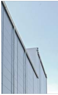
In nachhaltiger Leichtbauweise errichtet: OPAL
