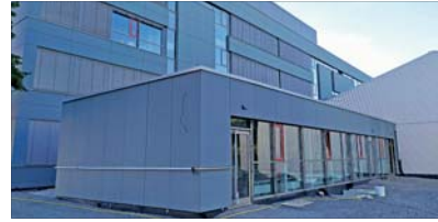
Die Generalsanierung des Schulhauses der Schillerschule ist abgeschlossen. Foto: Kranzcoch
