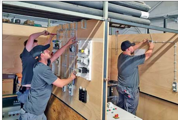
In den Lehrboxen in der Werkstatt kann jederzeit geübt und Simultansituationen nachgestellt werden. Foto: Remp
