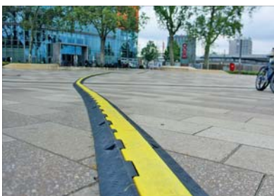
Der Kabelkanal der auf dem Lindenhofplatz installierten provisorischen Blindenleitführung bleibt vorerst, wie er ist. Foto: Kranczoch
