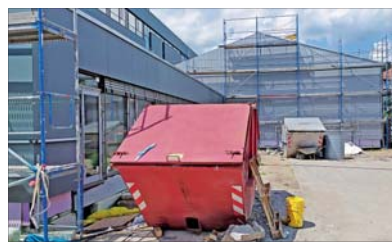
Der Bau der neuen Sporthalle an der Schillerschule wird vom Land mit fast 500.000 Euro gefördert. Foto: Kranczoch
