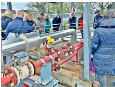
Geowissenschaftler Dr. Thomas Köbel erklärt anschaulich das Verfahren der Tiefengeothermie in Bruchsal. Foto: zg
