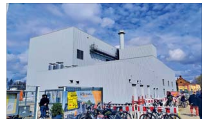
Der Bau des Heizkraftwerks in unmittelbarer Nachbarschaft des Sportanglervereins SAV läuft nach Plan.
