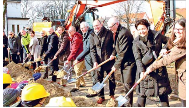
Kirche und Stadt eröffnen mit den Kindergartenkindern von Maria Hilf (Almenhof) und St. Josef (Lindenhof) die Bauarbeiten an der neuen katholischen Kita auf dem Almenhof mit einem gemeinsamen Spatenstich. Foto: kathma
