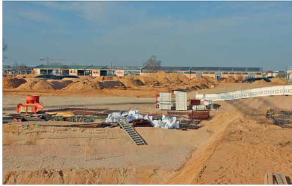
Südlich der U-Halle laufen bereits die Bauarbeiten für den neuen Betriebshof Grün.
