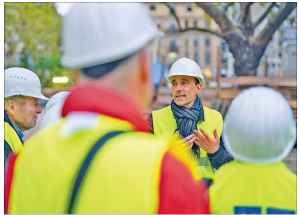
Baustellenführung mit Marcus Augsburg, Technischer Betriebsleiter und Projektleiter Generalsanierung. Foto: NTM/Maximilian Borchart
