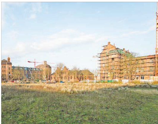
Die Arbeiten laufen auf Hochtouren: Auf Turley entwickelt Tom Bock das Quartier.
